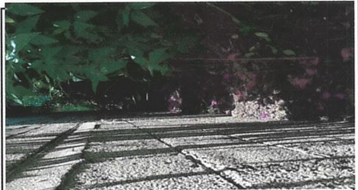
Foto 4: parte de atrás de la escuela se necesita remodelar
